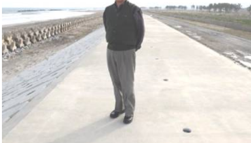
復旧した海岸堤防 (亘理町)
